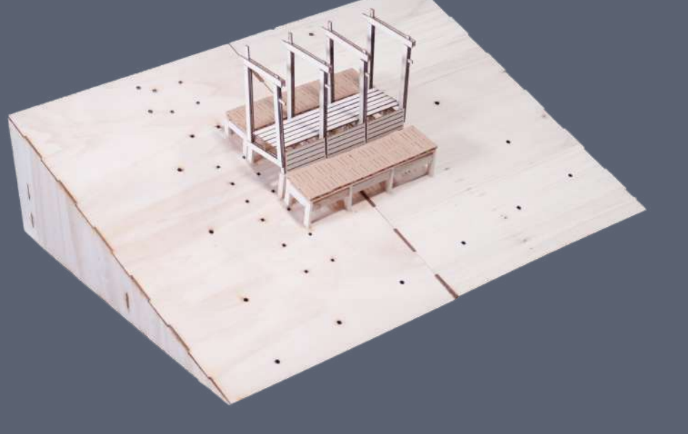
FASE 5 : MONTAGGIO DEI TRAVI SUPERIORE
