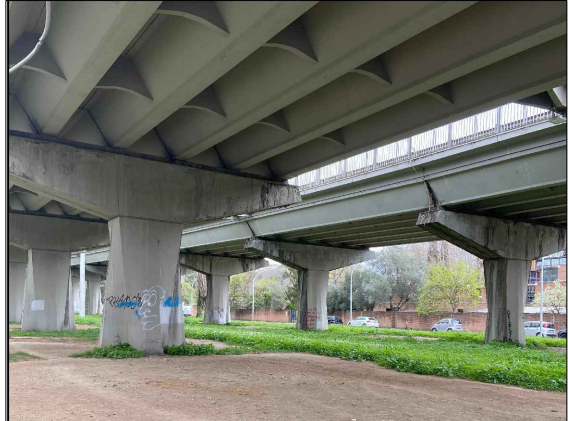
7 AREA SOTTOSTANTE IL VIADOTTO CORSO FRANCIA
