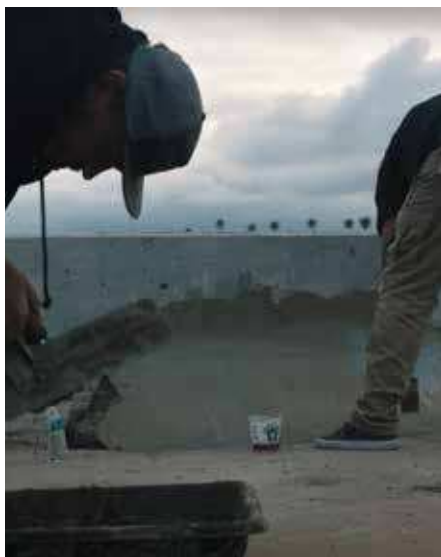
Ragazzi alle prese con la realizzazione di un raccordo tra un jersey e il suolo, San Diego, California.
