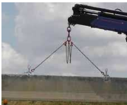
Pali per il sollevamento dei jersey barrier.
