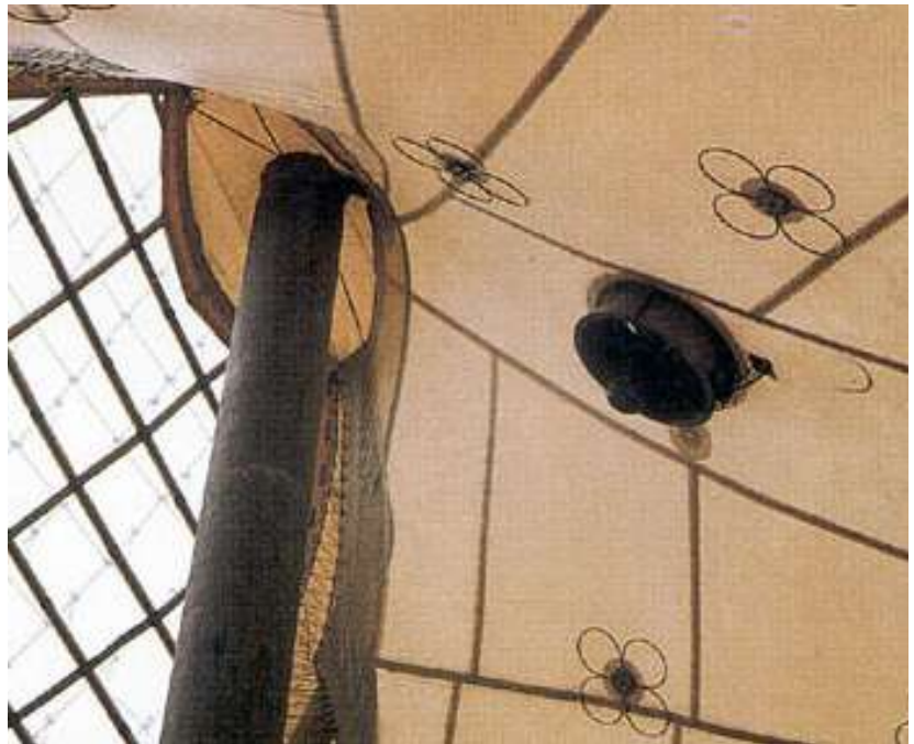
Dettaglio tensostruttura, dell'esposizione mondiale di Montreal, 1967.
