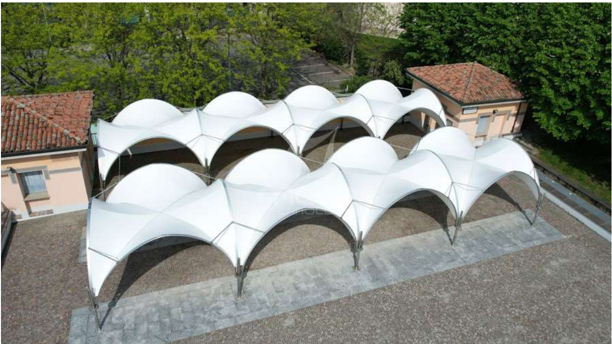
Tensostrutture a crociera, azienda Maco Technology, Brescia.
