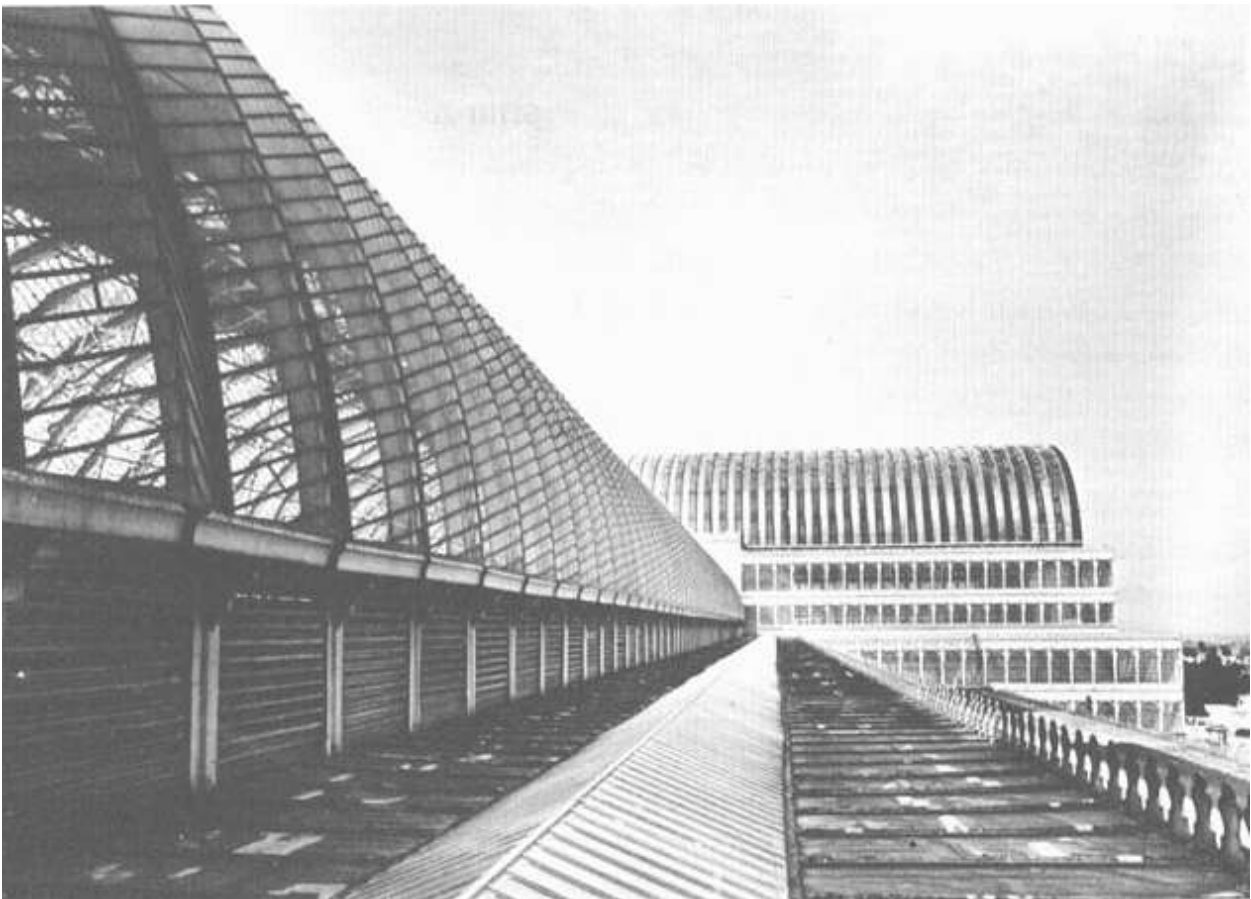
Vista esterna del tetto e delle volte del Crystal Palace dopo il trasferimento a Sydenham.
