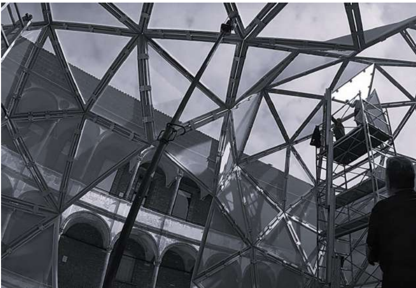
Montaggio struttura autoportante FuoriSalone Milano 2024, Amazon.
