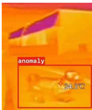
Scanione per anomalia termica
