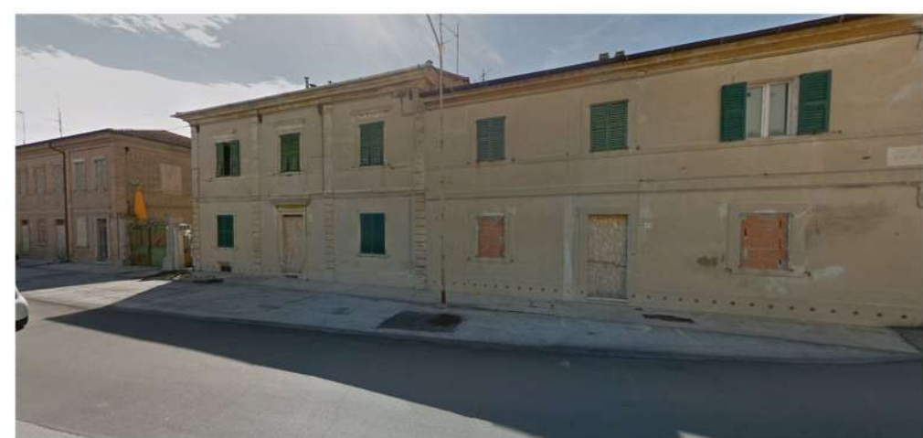
Edifici sul fronte stradale di piazzale Nino Bixio, attualmente inutilizzati, il loro stato di abbandono si riflette sull'immagine dell'intera zona.
