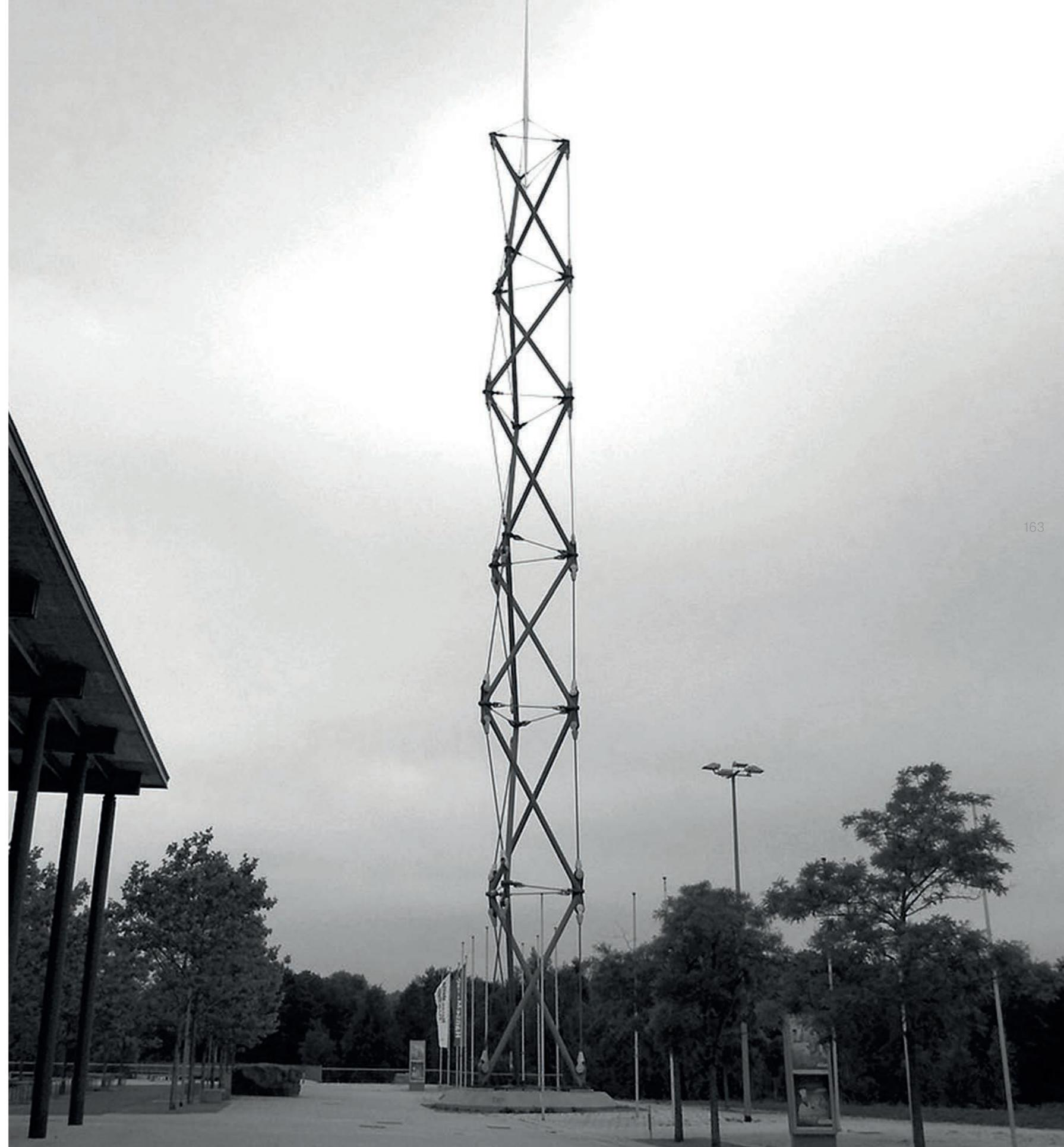
Tale forza di pre-tensione di progetto nei cavi diagonali è di 1200 kN e di 1500 kN per i puntoni tubolari compressi.
