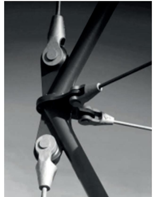
Ogni simplex è composto da 3 tubi in acciaio  $\varnothing$  273 mm. con uno spessore variabile fra i 12 e i 40 mm. e 6 cavi in acciaio ad alta resistenza, 3 orizzontali ( $\varnothing$  30 e 50 mm.) e 3 verticali ( $\varnothing$  50 e 75 mm.).
