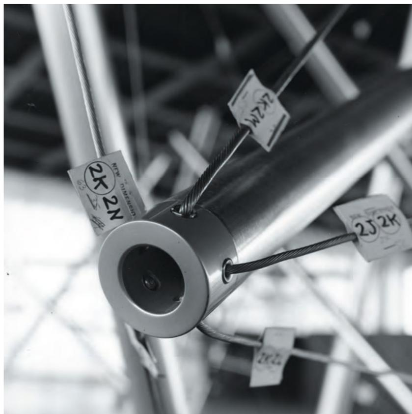
Dettaglio del giunto brevettato da Snelson
