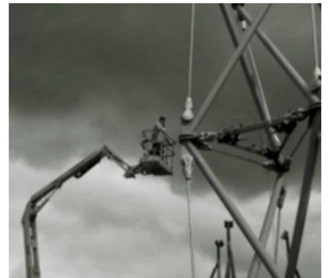
**Un sistema di tensegrità si stabilisce quando un insieme di compressioni discontinue interagisce con un insieme di componenti di trazione continua per definire un volume stabile nello spazio.**
