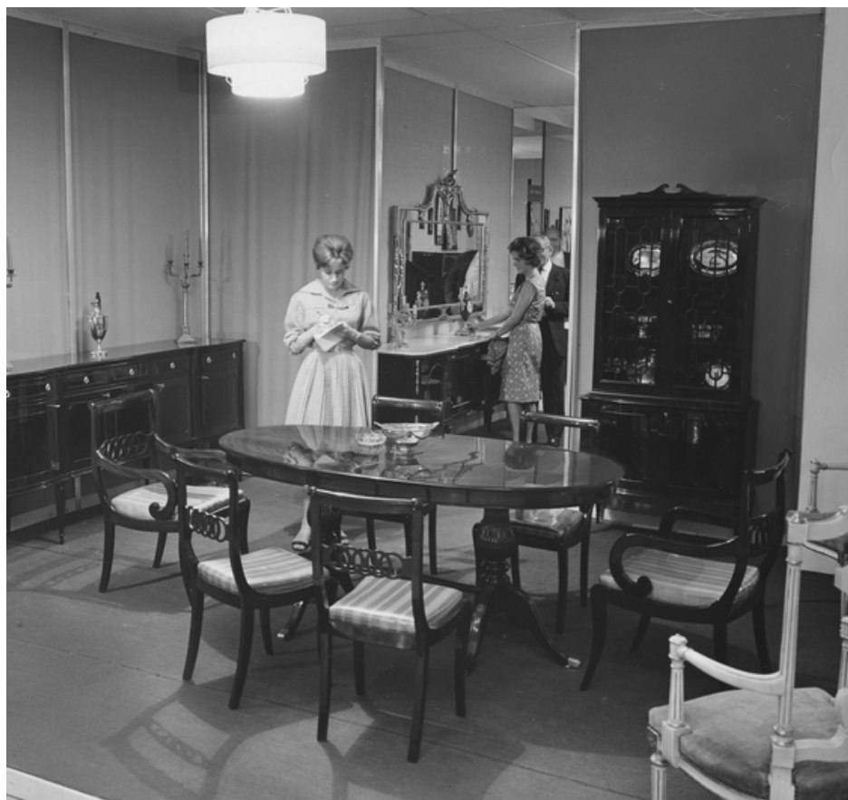
Interno del Primo Salone del mobile Fiera Milano 1961
