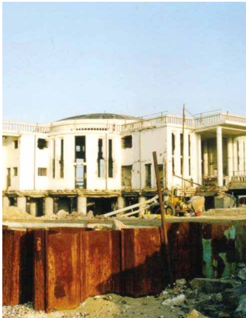
Ristrutturazione Rotonda a mare, 2006
