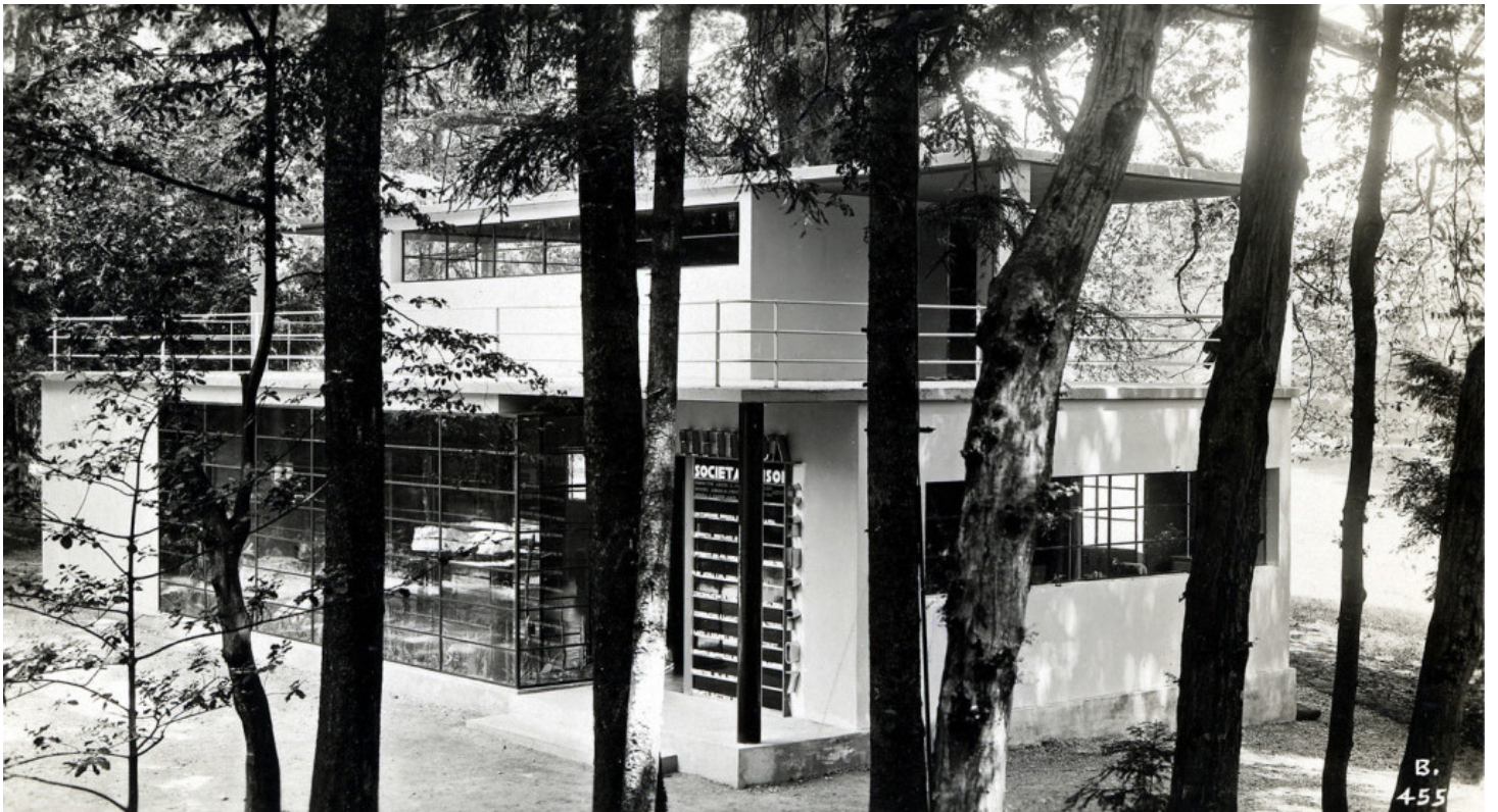
Esterno casa elettrica. Fonte: Archdap
