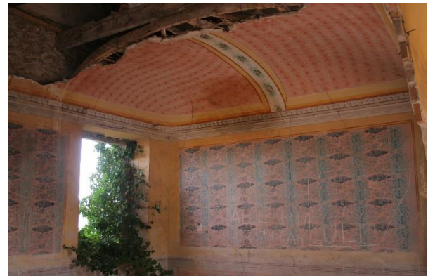
Fig. 14 - Faraone, falsa volta a padiglione costituita da centine ricavate da tavole di pioppo sui cui sono chiodate stuoie di canne sezionate.
