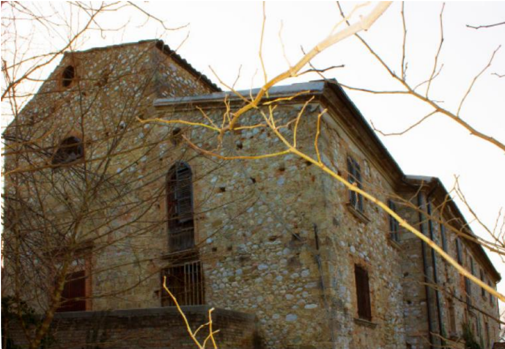
34 Scorcio nord-ovest del complesso della chiesa e della canonica 59
