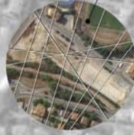
Area soggetta a demolizioni
