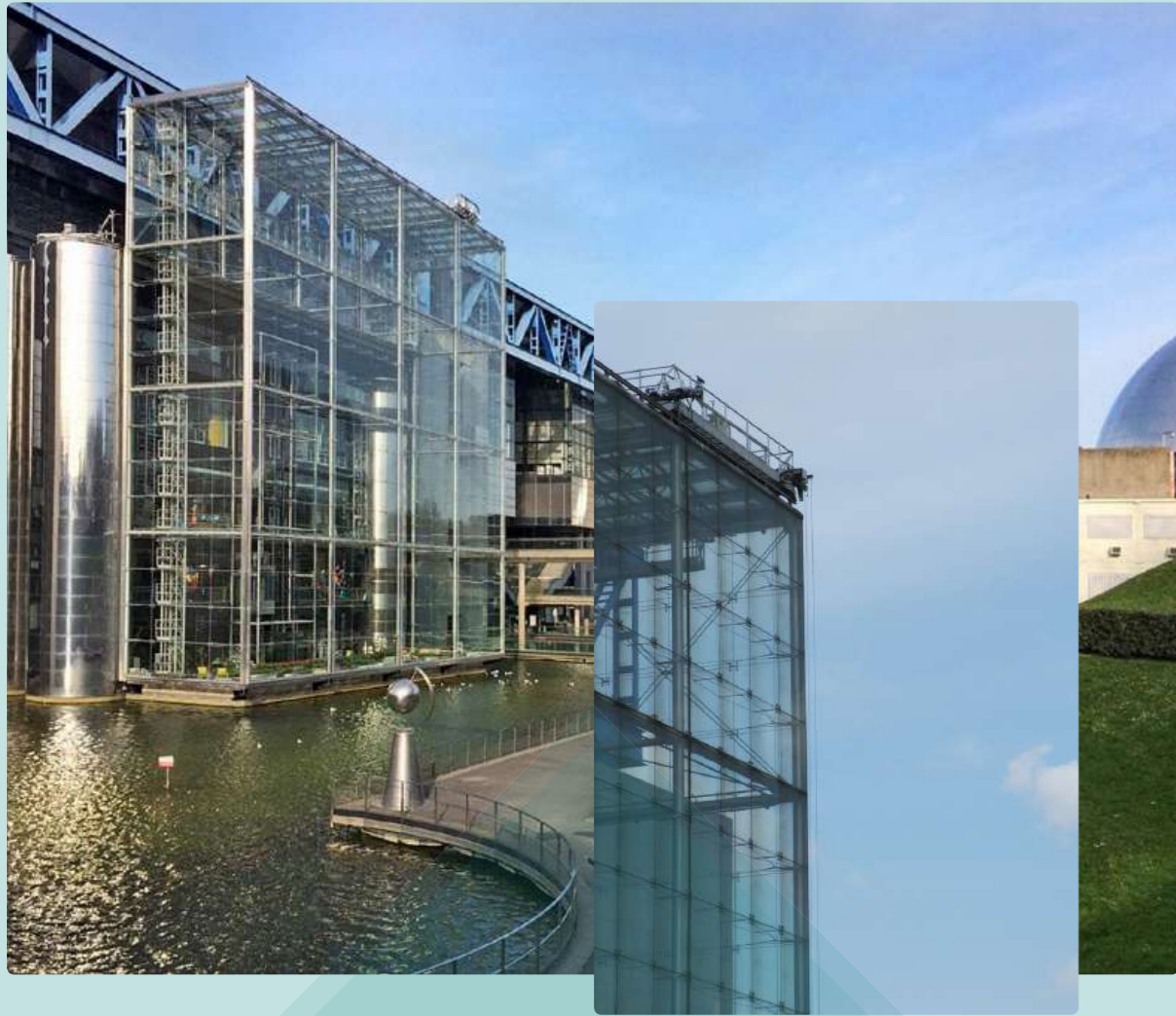
Le SERRE DE LA VILLETTE (Parigi). il vetro strutturale viene usato per donare trasparenza all'edificio
