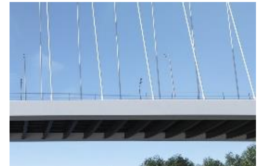
Vista impalcato dal basso
