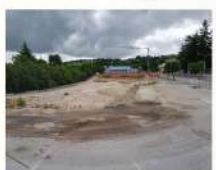
Sito ex Scuola Superiore ITIS, crollata a causa del sisma. Il sito ora si presenta come un grande spazio, che può essere un'opportunità di centralità per il quartiere Uvaiole.
