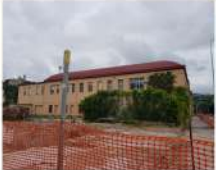
Ex-Oratorio Don Orione, un punto importante per l'aggregazione del quartiere. La struttura si presenta inagibile dopo il sisma.
