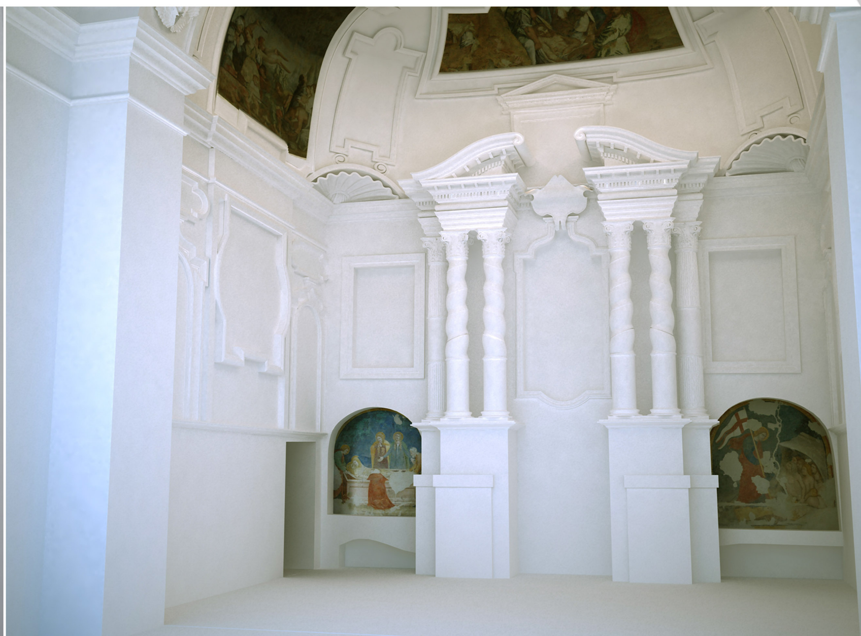
FONDALE DELLA NAVATA ALLO STATO ATTUALE
