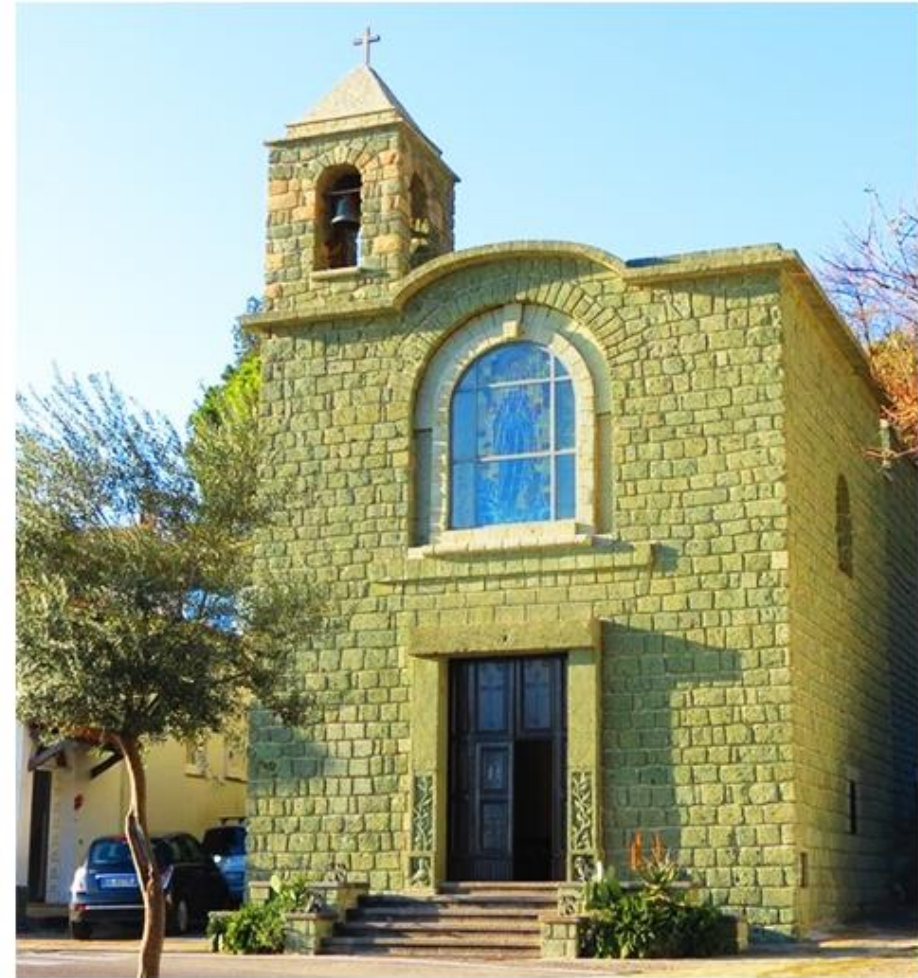
CHIESA DI SAN NICOLA AL CIGLIO IN PIETRA VERDE REALIZZATA DA UN ARTIGIANO LOCALE
