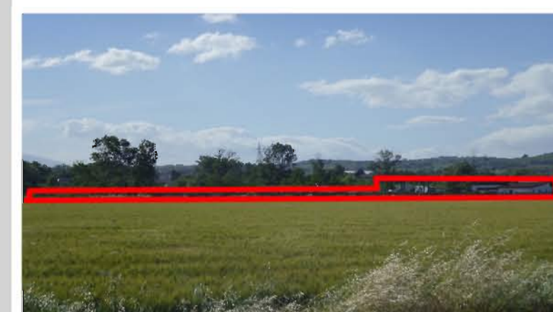
IMPIANTI TECNOLOGICI: sono a diretto contatto con i seminativi e l'area fluviale adiacenti, questo influisce sull'impatto visivo ma anche sul rischio inquinamento
