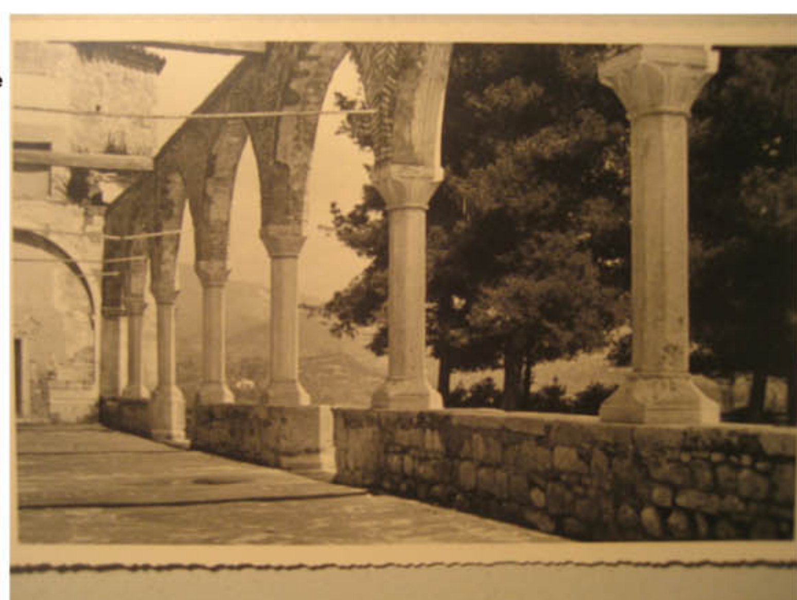
Dopo il 1940 Lavori di riapertura arcate e rifacimento copertura
