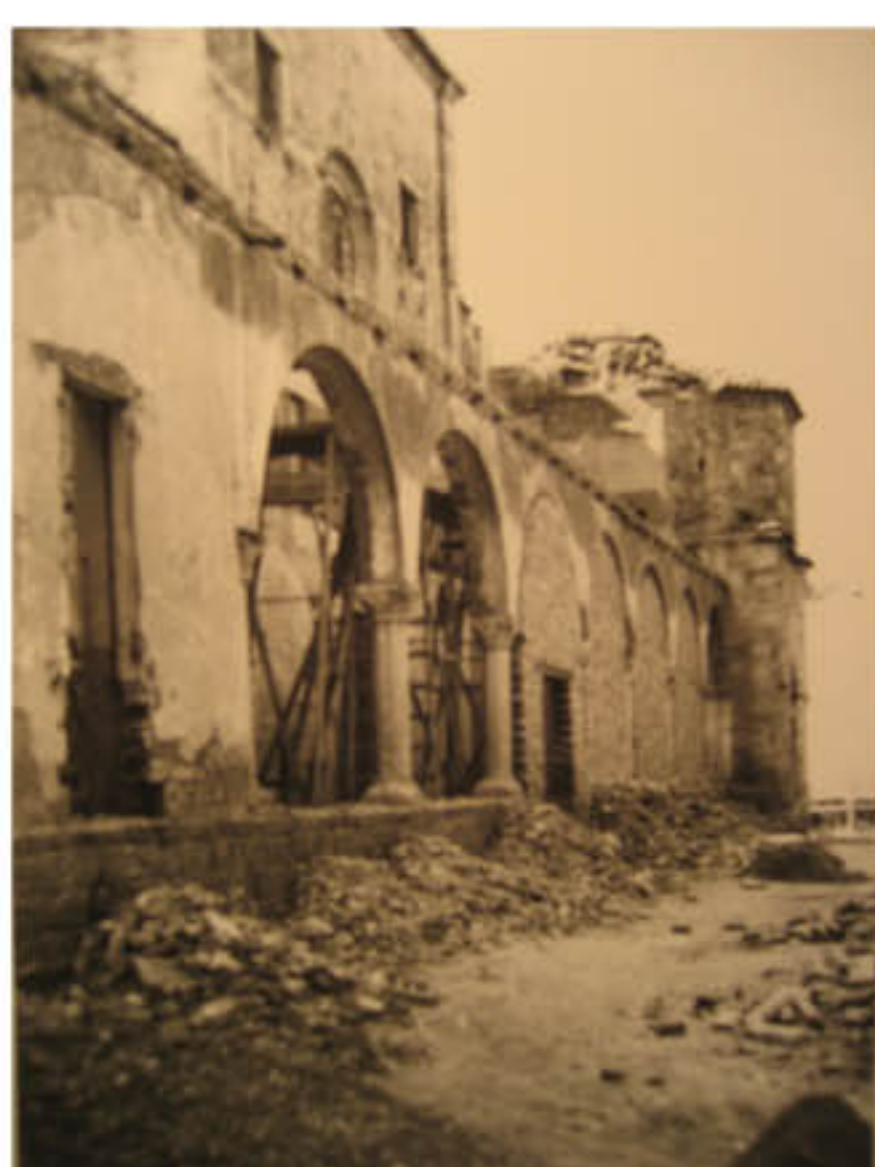
Dopo il 1940 Lavori di riapertura arcate e rifacimento copertura
