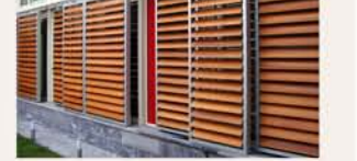
Blind solari Sistema di schermatura scorrevole con struttura in alluminio e listelli in legno.
