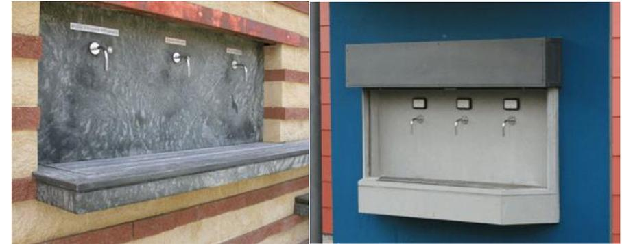
La struttura “gatzebo” può essere di due tipi: prefabbricata e non. Entrambe sono parzialmente coperte, ad eccezione del locale di erogazione. La tipologia prefabbricata corrisponde a una evoluzione del sistema. Ulteriore evoluzione del sistema è la tipologia di Casa “container”. Una struttura totalmente prefabbricata, che si posa a secco, con l’utilizzo di elementi componibili.
