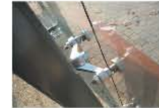
Fig.12 particolare attacco: appoggio al metallo in metallo
