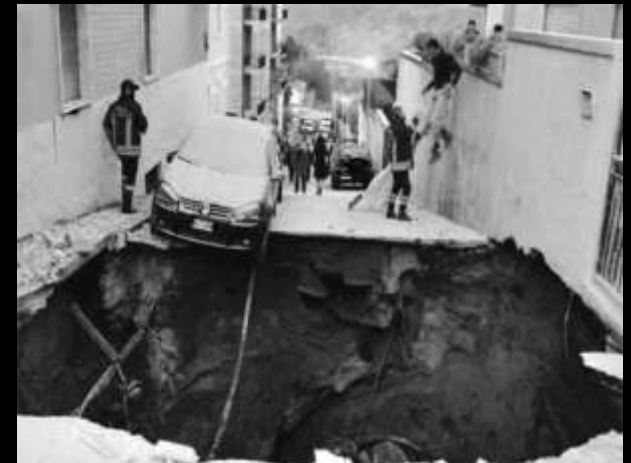
SINKHOLE (sprofondamento del terreno dopo il sisma nella CITTA' de L'AQUILA)
