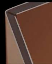
1. PARAPETTO IN RAME (pannello composito tecnologico TECU Bond)
