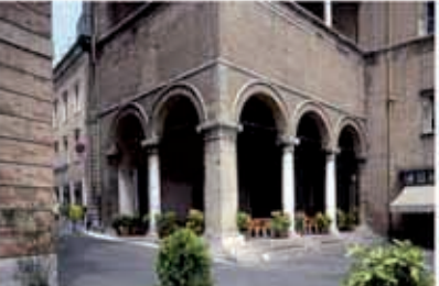
LOGGIA DEI MERCANTI, ADIACENTE AL PALAZZO DEL COMUNE, È COSTITUITA DA UN PORTICO A TRE ARCHI E DA UN'ALTA LOGGIA. È DI MATRICE TOSCANA E RIPORTA UN'ISCRIZIONE DI GIULIO II. FÙ COSTRUITA, INTORNO AL 1504, DA CASSIANO DI FABRIANO PER ALESSANDRO FARNESE. NEL 1641 UN GOVERNATORE PONTIFICIO LA TRASFORMÒ NELLA SUA CAMERA DA LETTO. FÙ RIAPERTA NEL 1905.
