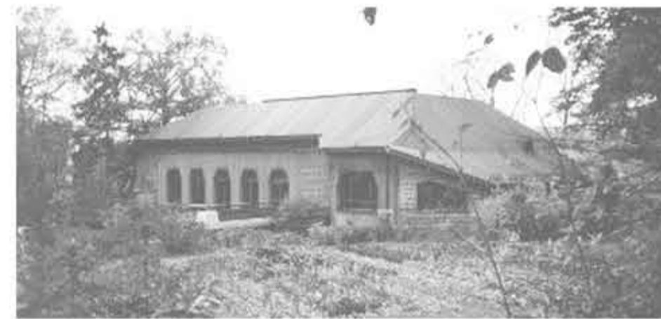
Schule Nürnberg, Turnhalle
