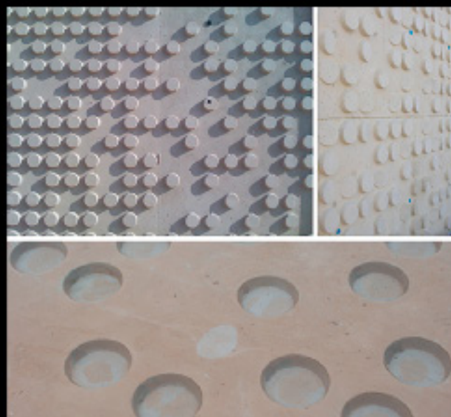
Facciate in calcestruzzo, utilizzando pannelli di poliuretano come calce per realizzare cilindri in rilievo sul materiale
