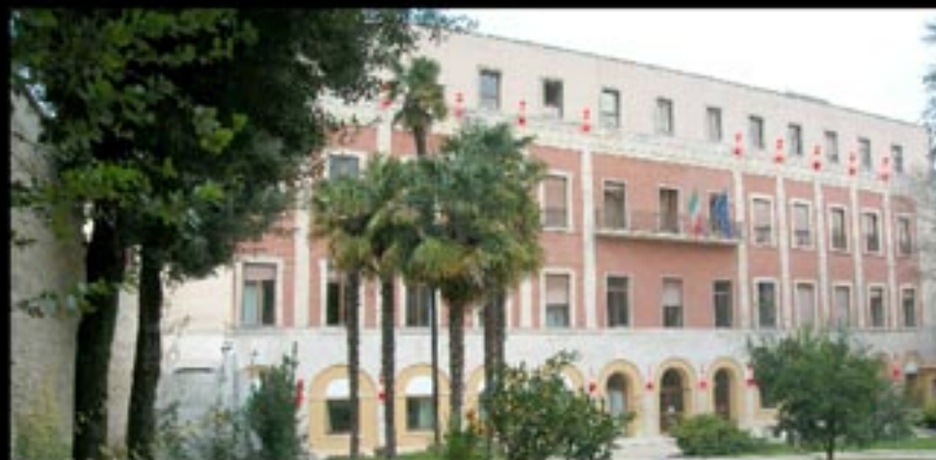
POSIZIONAMENTO DEI CORPI ILLUMINANTI
