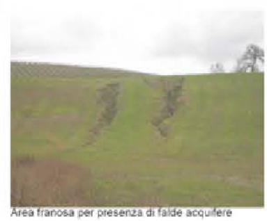
Area franosa per presenza di falde acquifere
