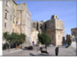
Il tessuto urbano del centro storico e della prima espansione urbanistica è caratterizzato da edifici con struttura portante in tuil e pietra leccese.
