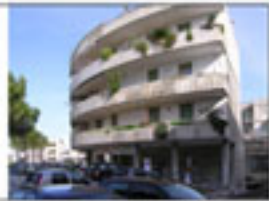
Il tessuto urbano periferico alto di nuova costruzione è caratterizzato da edifici con struttura portante esclusivamente in C.A. e tamponamenti in laterizio.
