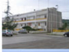
Questo progetto fa parte di un tessuto urbano basso e denso caratterizzato da edifici in linea con struttura in C.A. e tamponamenti sia in laterizio che in tuil, ed è delimitato da edifici alti con la stessa tipologia costruttiva.
