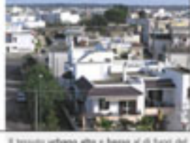
Il tessuto urbano alto e basso al di fuori del centro storico è caratterizzato da edifici realizzati sia con struttura portante in tuil che in C.A. a seconda dell'anno di costruzione.
