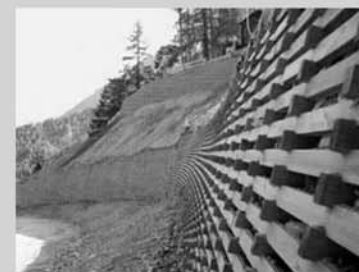
Muro di sostegno cellulare in legno: sistema costruttivo e applicazione reale
