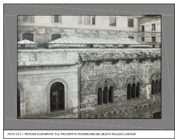
FOTO 013 - TRIFORE RINFORCATE SUL PROSPETTO POSTERIORE DEL NUOVO PALAZZO DELLA CARISAP
