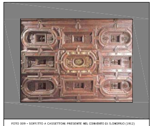
FOTO 009 - SOFFITTO A CASSETTONI PRESERVITO NEL CONVENTO DI S. ONOFRIO (1912)
